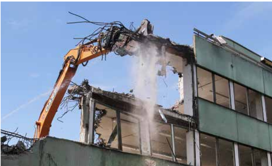
Rückbau eines Industriegebäudes im Raum Schweizerhalle. Gebäude und Infrastrukturbauwerke sind unsere Ressourcen für morgen. Durch die Verwertung von Rohstoffen werden Materialkreisläufe geschlossen und es sind weniger Eingriffe in die Natur notwendig.
