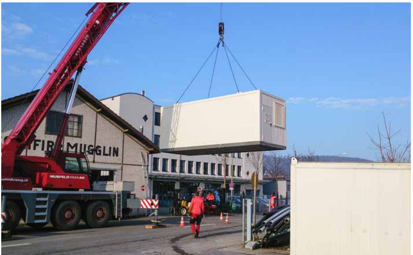
Bis zur Fertigstellung des Gefängnisses Muttenz wurden im Januar 2014 in einer Industriehalle nahe Liestal Gefängniscontainer installiert.
