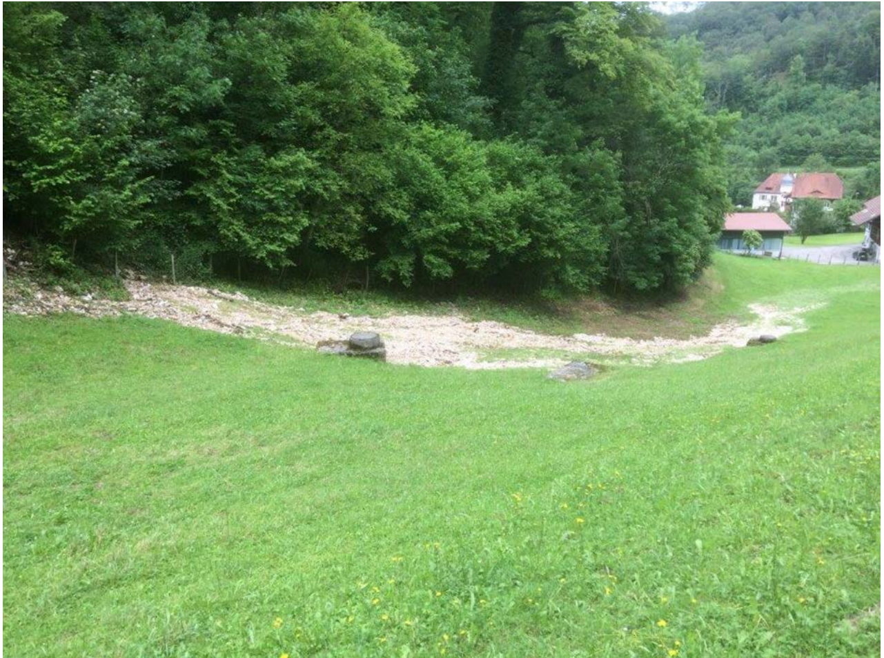
Abbildung 4: Folgen des schlechten Zustandes Leitung AIB nach einem Starkregenereignis am 07.06.2016
