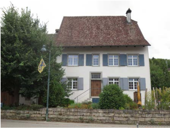
Lupsingen, Seltisbergerstrasse 12, Dachreparatur
