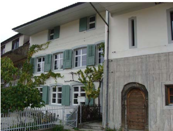
Gelterkinden, Tecknauerstrasse 17, Sanierung
