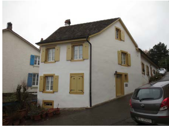
Münchenstein, Münchstrasse 1, Fassadensanierung
