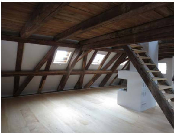
Arlesheim, Sundgauerhof, Sanierung/Umbau
