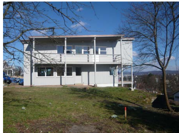
Binningen, Haus Schmidt, Sanierung
