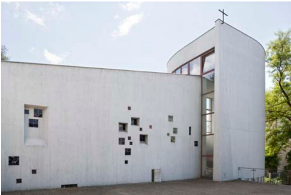
Birsfelden, Kirche Bruder Klaus, Dachsanierung
