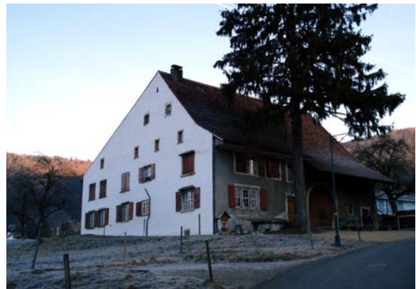
Reigoldswil, Wohnhaus/Museum, Aussenrenovation
