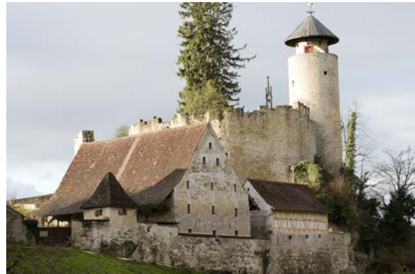
Arlesheim, Schloss Birseck, Riegelbau, Sanierung
