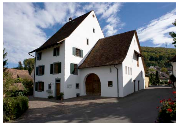
Pratteln, Wohnhaus, Umbau und Aussenrenovation
