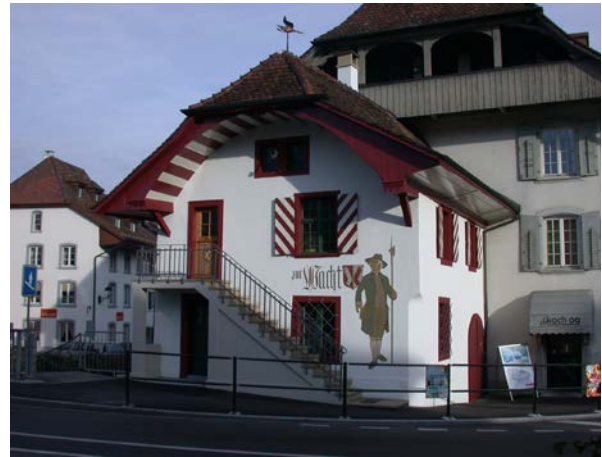
Sissach, Wachthaus, Aussenrenovation
