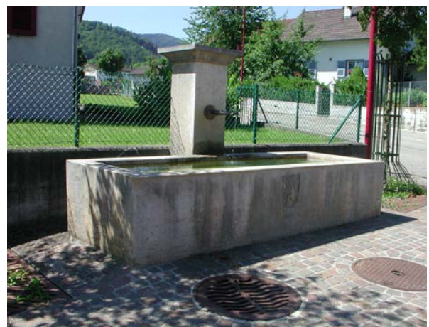
Wahlen, Brunnen Grindelstrasse, Renovation
