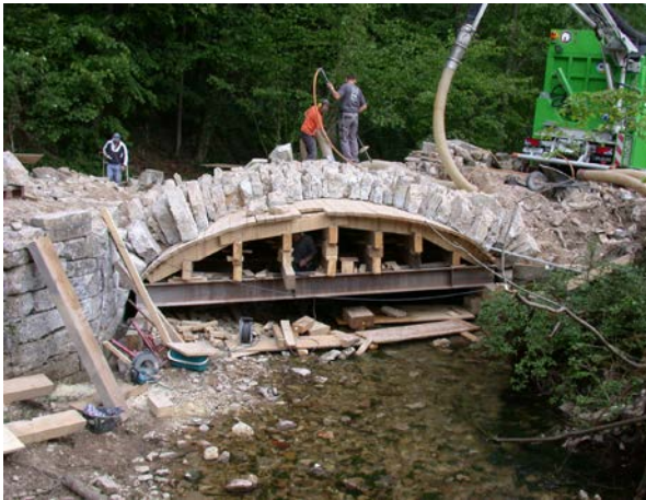
Reigoldswil, Bütschenbrücke, Sanierung
