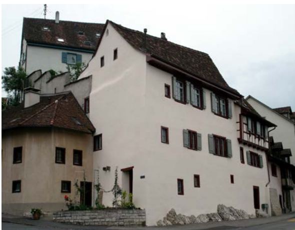
Münchenstein, Wohnhaus, Aussenrenovation
