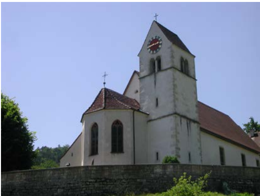
Dittingen, ref. Kirche, Sanierung Friedhofmauer
