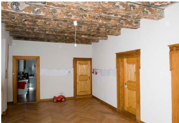
Pratteln, Pfarrhaus, Innenrenovation
