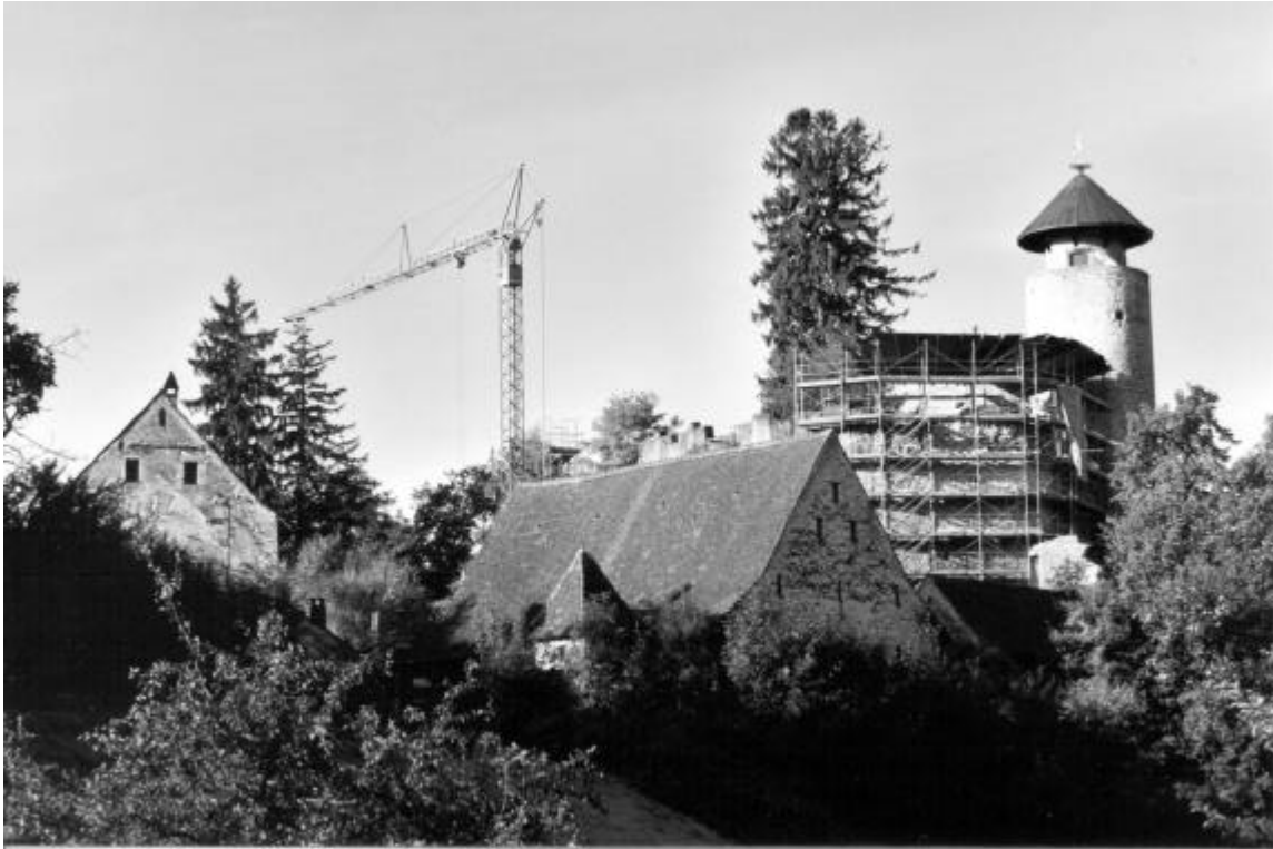
Sanierung des eingestürzten Teilstückes der Nordmauer 2000 / 2001
