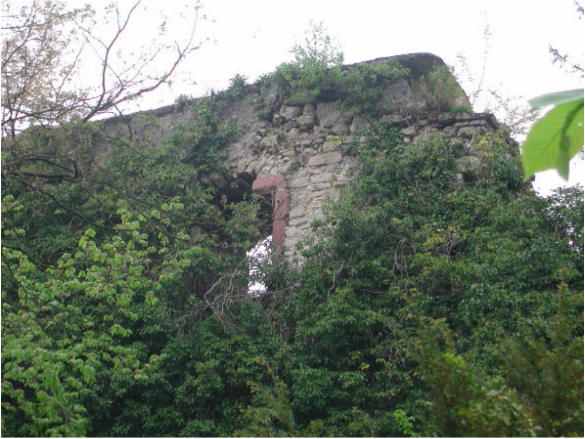
Zustand der Südmauer April 2002
