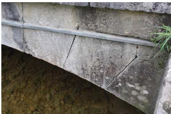
Schäden an der Brücke (Foto HOCHBetrieb GmbH)
