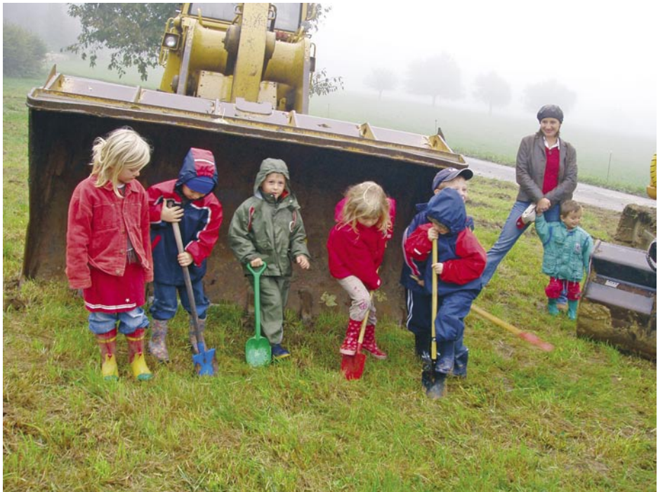
«Chindsgi-Chinder» beim Spatenstich vom 4. Oktober 2005 zum Neubau des Kindergartens
