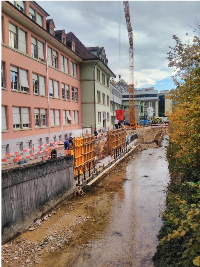
Aufbau der neuen Bachmauer
