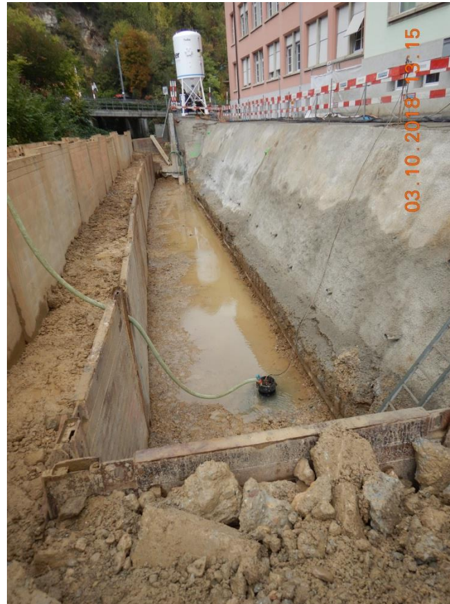
Einbau Bachrückhalte-System
