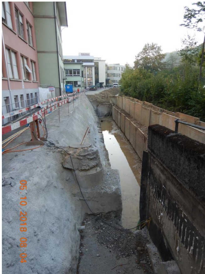
Derzeit ist Stillstand auf der Baustelle
