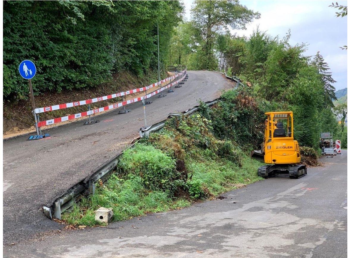
31.08.: Leitplanken entfernt, erste Rodungen, abgesperrter Fussweg
