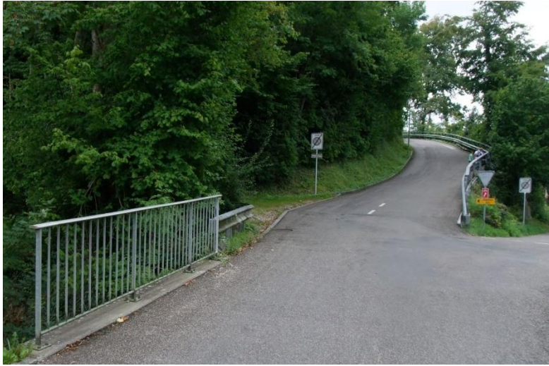
Situation vor Baubeginn
