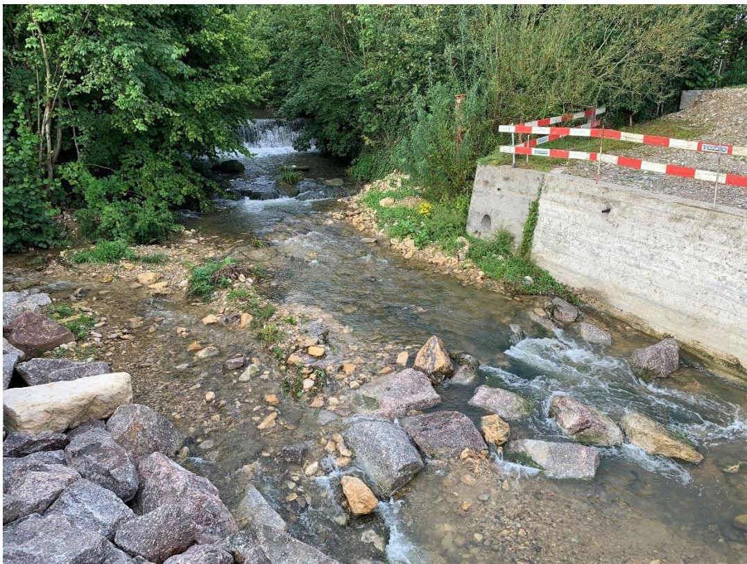
Vordere Frenke an der Ribigasse: Aufwertung der Bachsohle
