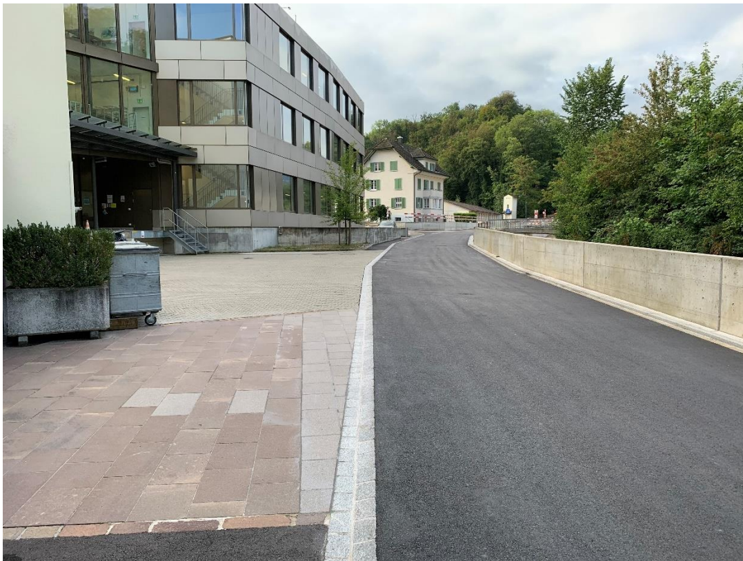
Ribigasse: neue Strasse, neue Bachmauer, neue Vorplätze
