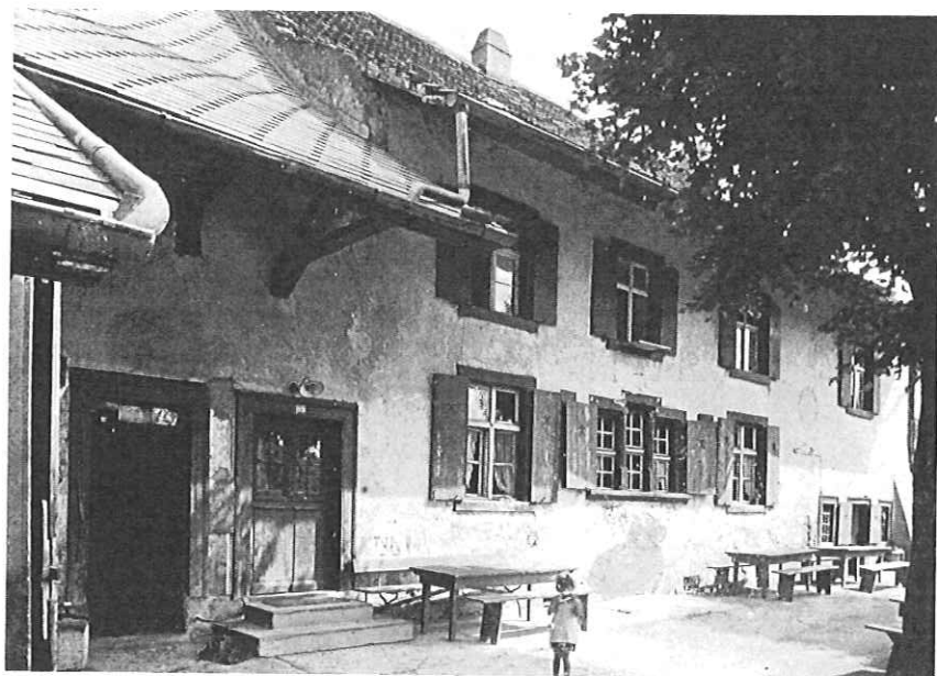
12 Berghaus «Oberbölchen» vor dem Umbau
