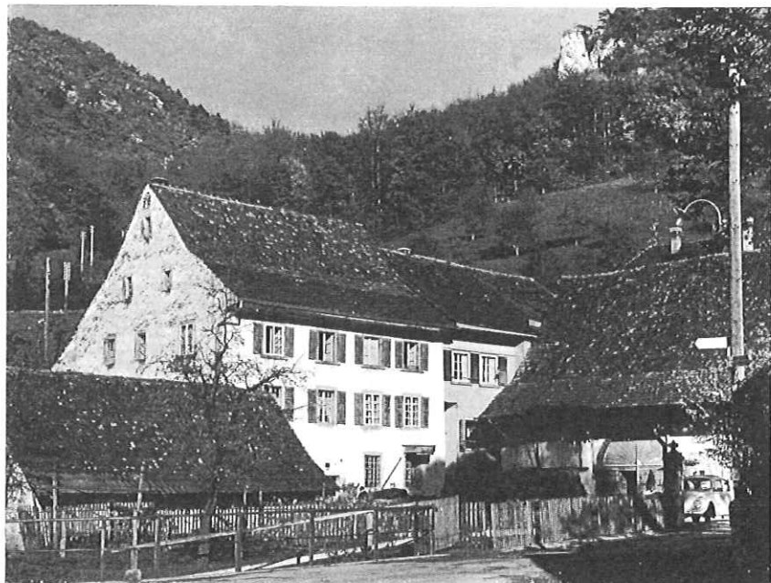
4 Die ehemalige Mühle
