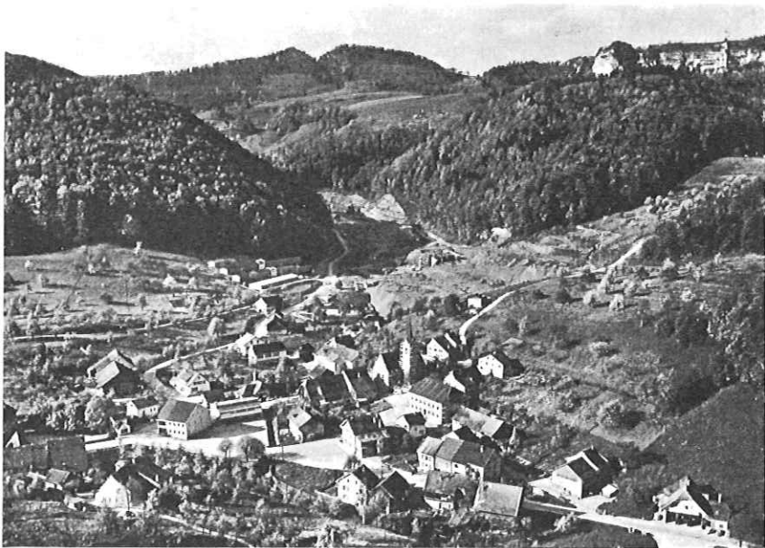
2 Eptingen mit Belchen und Baustelle Belchentunnel, 1966
