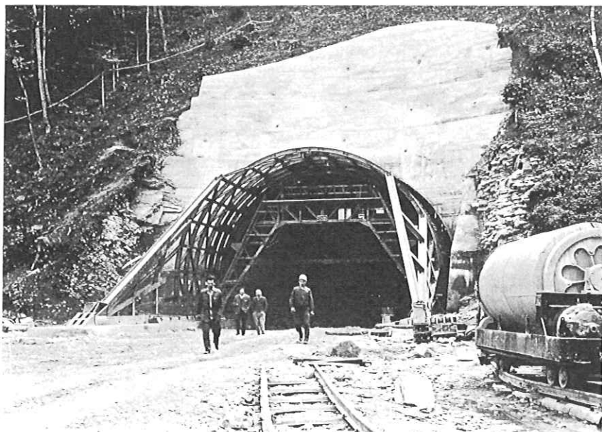
17 Nordportal des Belchentunnels während des Baues
