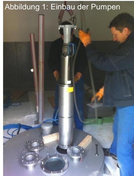
Abbildung 1: Einbau der Pumpen
