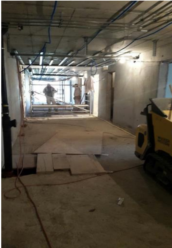
EG – Gangbereich Garderoben
