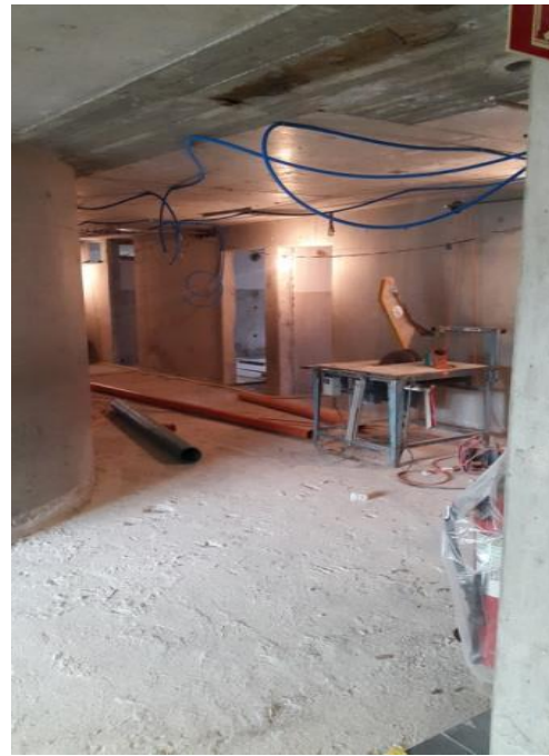
EG – Bereich Turnhalleneingang
