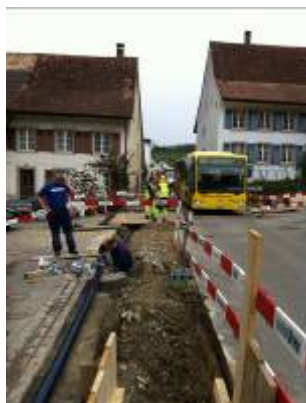
Beginn der Aushubarbeiten im Kreuzungsbereich Mitteldorf 1. Etappe (31.03.2011)
