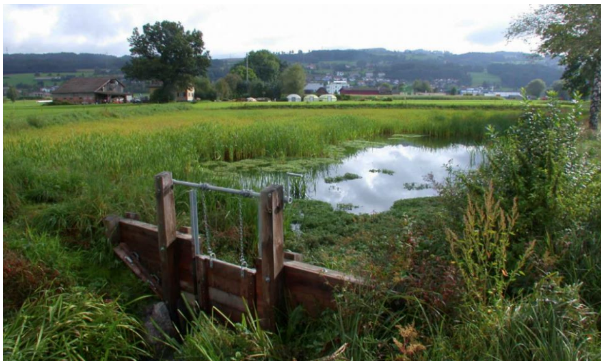
Bild: Retentionsanlage Geuensee LU
