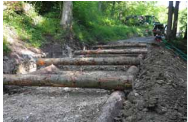
Erstellung eines Holzkastens, Waldenburg
