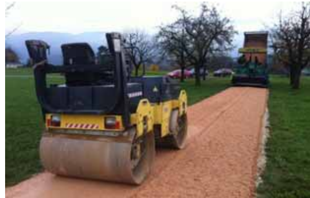
Neubau eines Mergelweges, Blauen
