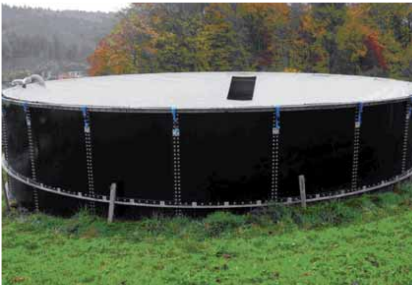
Abdeckung eines offenen Güllesilos mit einer Folie
