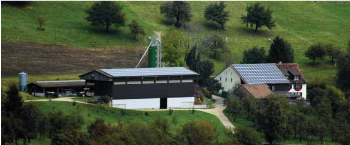
Photovoltaikanlage mit einer Leistung von 51,5 kWp in Reigoldswil
