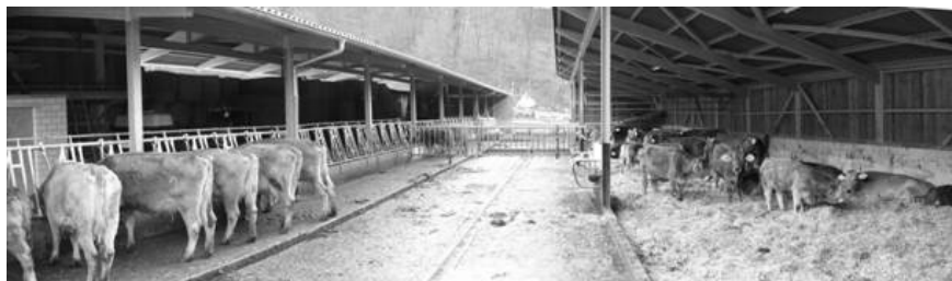
Duggingen, Siedlung "Geisler": Neubau eines tiefgestreuten Mehrgebäudestalles für 36 Mutterkühe und Kälber
