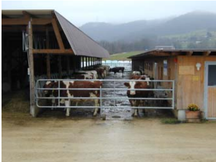
Bilder: Neubau Milchviehstall der Tierhaltungsgemeinschaft Buchsmet, Anwil. Es handelt sich um einen offenen Mehrgebäudestall mit beschränktem Bauvolumen und minimalem Ausbaustandard. Für die Holzkonstruktion wurde ausschliesslich "Lothar"-Sturmholz aus eigenem Wald verwendet.
