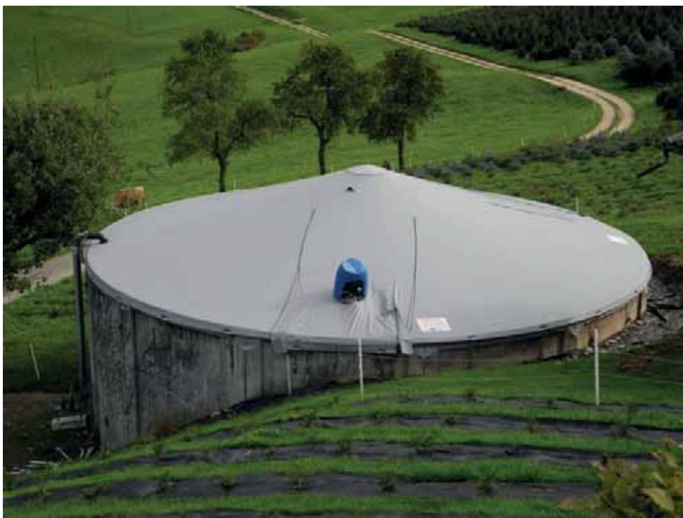
Abdeckung einer offenen Güllegrube mit einem Zeltdach
