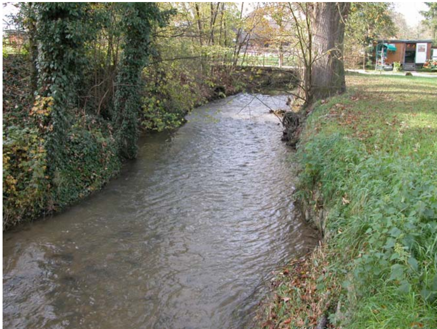
Abbildung 13: Stelle 4, Birsig in Biel-Benken: Die Bachsohle ist unver- baut; der Böschungsfuss wurde stellenweise gesichert.
