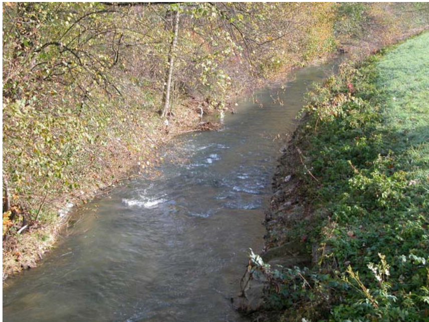
Abbildung 9: Stelle 2, Birsig unterhalb Oberwil: Die Bachsohle und der Böschungsfuss sind fast durchgehend verbaut.
