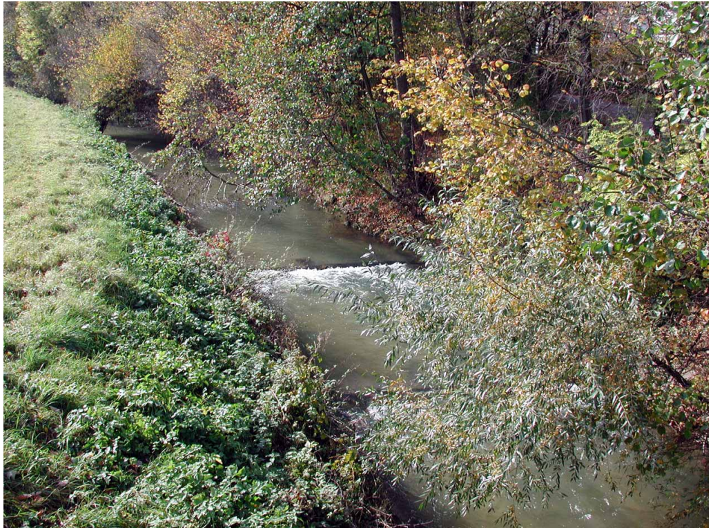
Abbildung 5: Birsigstrecke B2 zwischen Oberwil und Bottmingen. Ufer und Sohle sind durchgehend verbaut.
