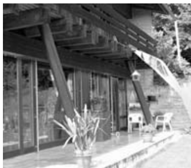
Rundholzstützen tragen das Haus und ermöglichen eine voll verglaste Südfassade.
