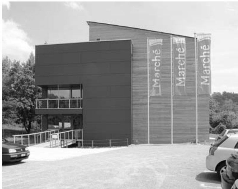
Das Marché-Gebäude überzeugt durch seine Schlichtheit. Eine hohe Arbeitsplatzqualität ist deutlich spürbar, die Tageslichtnutzung über die längsseitig verglaste Fassade ist dabei ein wesentlicher Bestandteil.
