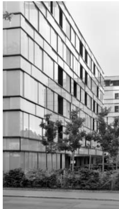
Eichgut Winterthur; MINERGIE-P, Erstellung 2005/2006
