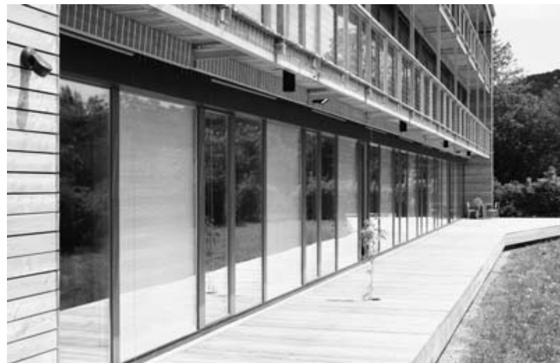
Bürohaus Marché, Kempthal, MINERGIE-P-ECO, Erstellung 2006/2007
