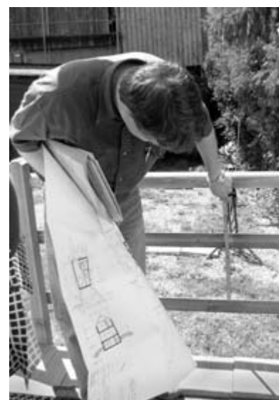
Der «Baupolizist» misst die Abstände zwischen den Latten; diese dürfen höchstens 12cm auseinander liegen.
