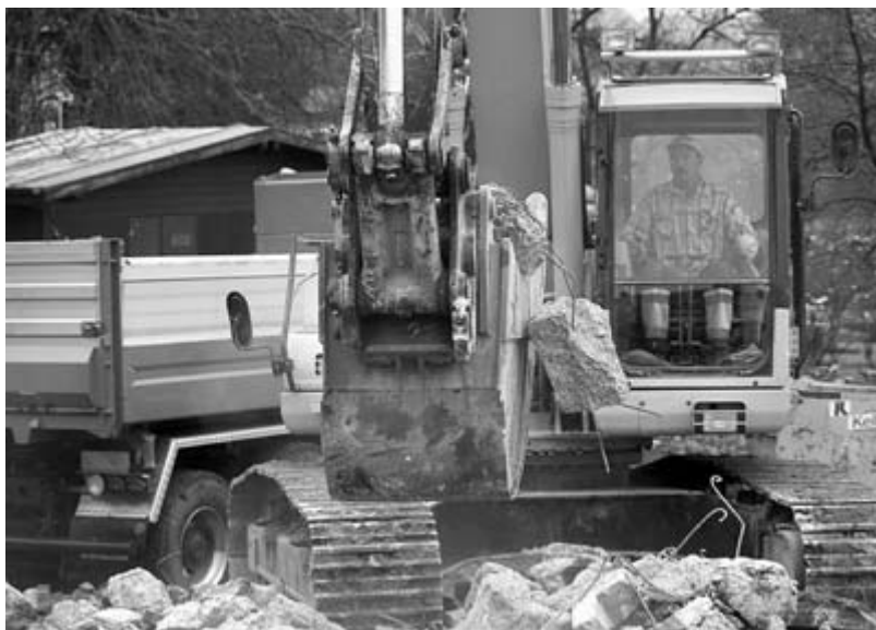
Rückbau eines belasteten Standortes, Abtransport des Materials zur Aufbereitungsanlage.
