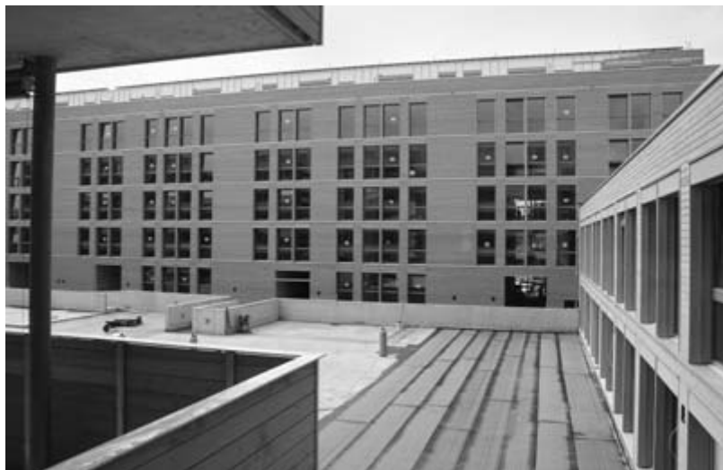
Eulachhof Winterthur, MINERGIE-P-ECO, Erstellung 2006/2007
