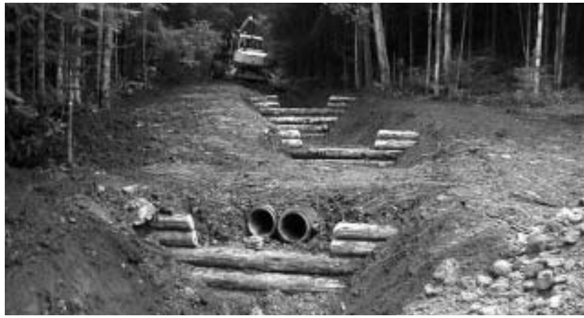
Wasserbausperre im Laufental.
