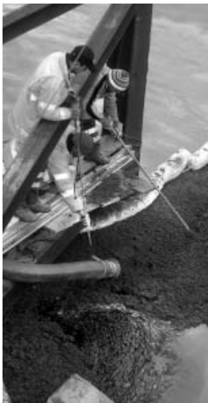
Absaugen von Schweröl und Bindemittel mit dem Saugbagger.
