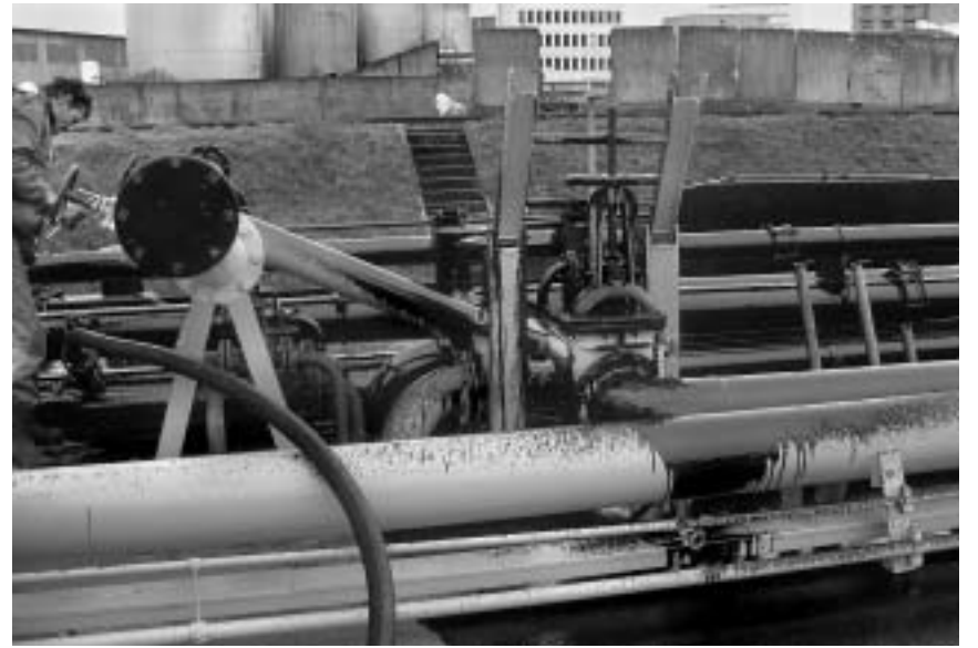
Verunreinigungen auf dem Schiffsdeck.
