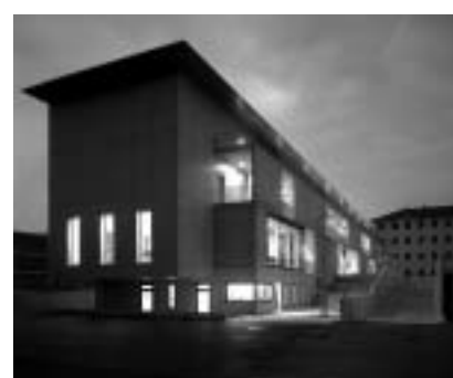
Das neu erstellte Dienstgebäude.
