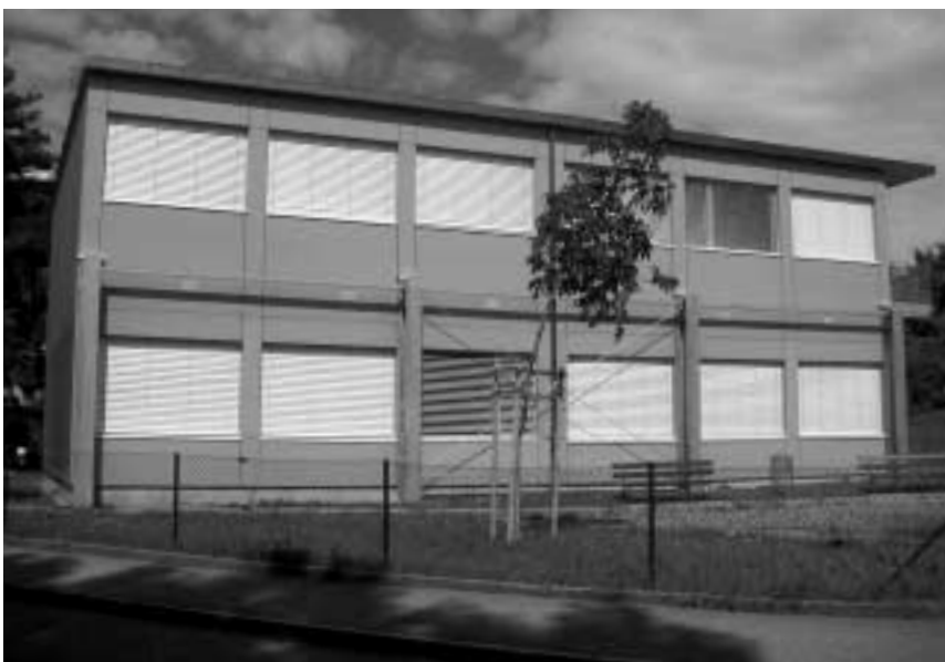
Der aufgestockte Pavillon nach den Umbauarbeiten.
