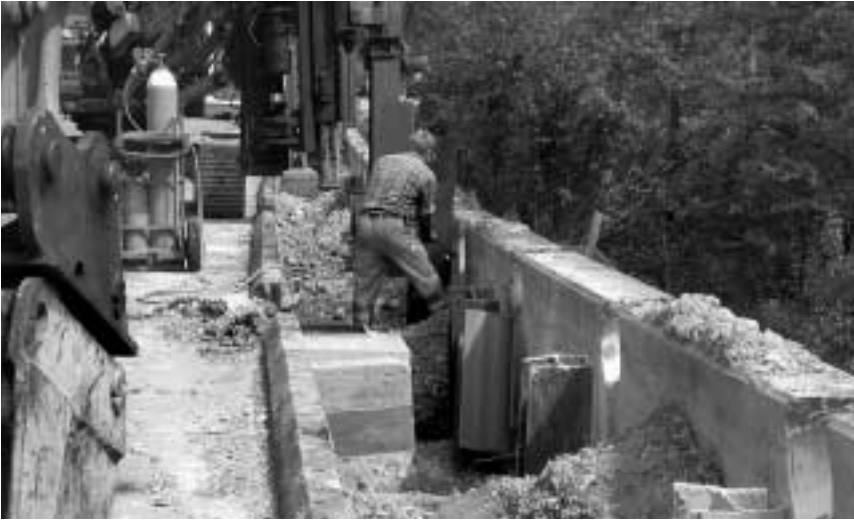
Abteufung der Pfähle in 7 Meter Tiefe.
