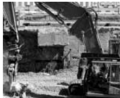
Dieselmotoren von Baumaschinen stossen gesundheitsgefährdende Russpartikel und Staub aus.
