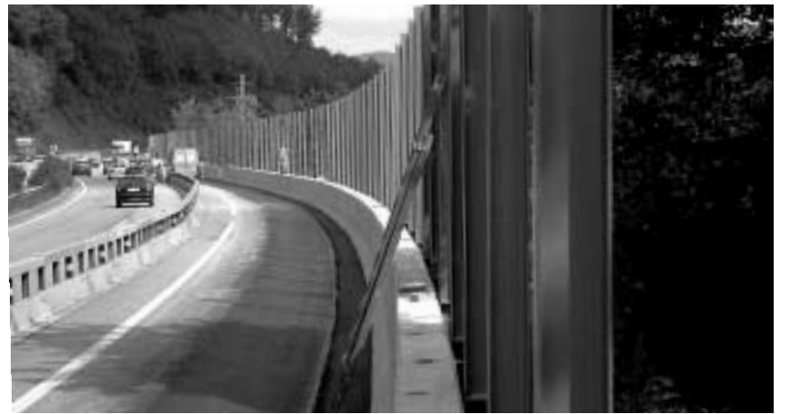
Die fertige Lärmschutzwand mit der Beton-Schutzmauer.
