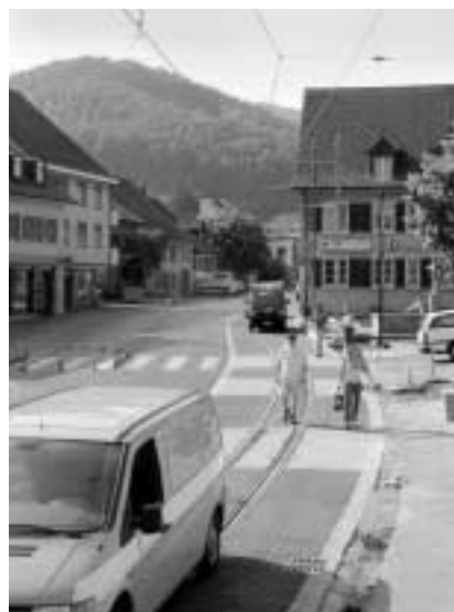
Woche 6 3. August Am 30. und 31. Juli ist der Deckbelag zwischen Winkelweg und Post eingebracht worden. Markierungsarbeiten, Verkabelungen für die Sicherungs-
