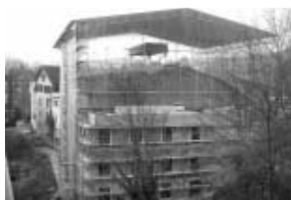
Der Dachstuhl steht bereit ...
