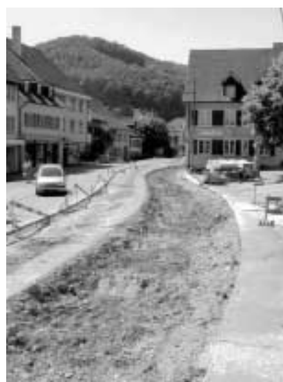
Woche 1 29. Juni Die Geleise sind auf einer Länge von 750 Meter komplett herausgerissen, der Gleisbau erfolgt von beiden Enden her.
