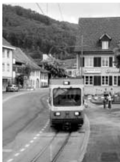
Woche 0 23. Juni (vor dem Umbau) Die Waldenburgerbahn verkehrt in der Strasse, vom Gegenverkehr lediglich durch eine Markierung abgetrennt.
