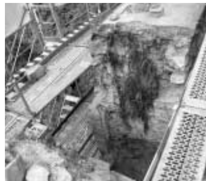
Abbruch der stark bewachsenen Mauerkrone.
