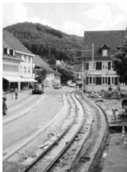
Woche 3 14. Juli Die Randabschlüsse sind versetzt und die Fahrbahn der Hauptstrasse wird für den Belageinbau vorbereitet. Ende Woche sind die Geleise auf der ganzen Strecke verlegt.
