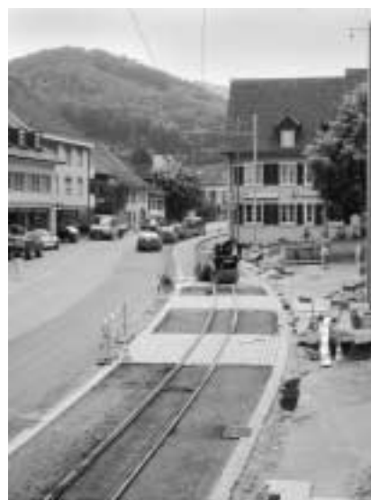
Woche 4 21. Juli Der Belag (Tragschicht) auf der Strasse und zwischen den Schienen ist eingebaut und die Übergänge über das Trasse der WB werden gepflastert.
