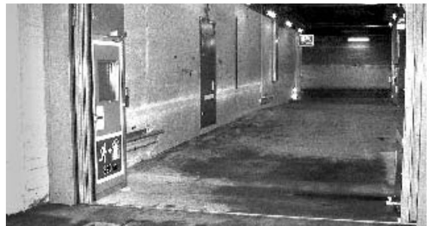
Offene Sicht in die andere Röhre: Geöffnetes Sicherheitstor in Tunnelquerverbindung.
