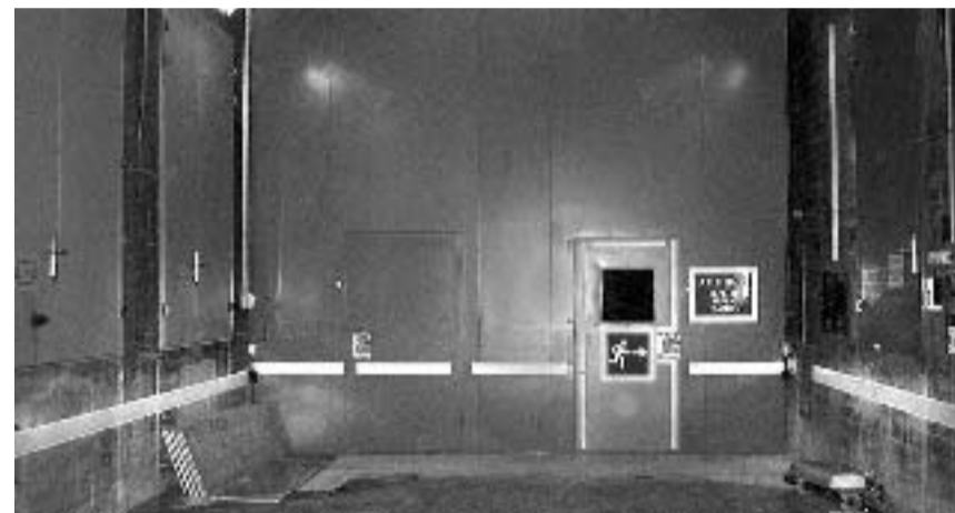
Geschlossenes Sicherheitstor mit kleiner Türe als Fluchtmöglichkeit.
