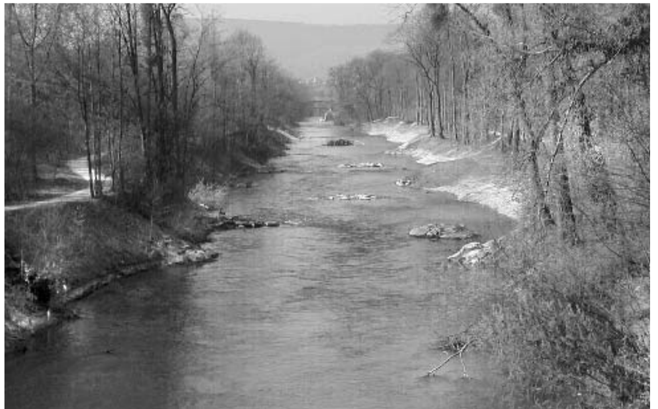
Die «neue» Birs nach Abschluss der Bauarbeiten.
