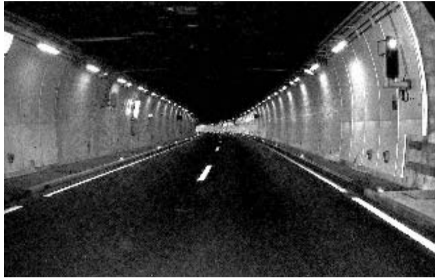
Dank besserer Beleuchtung gut sichtbare Bankette.
