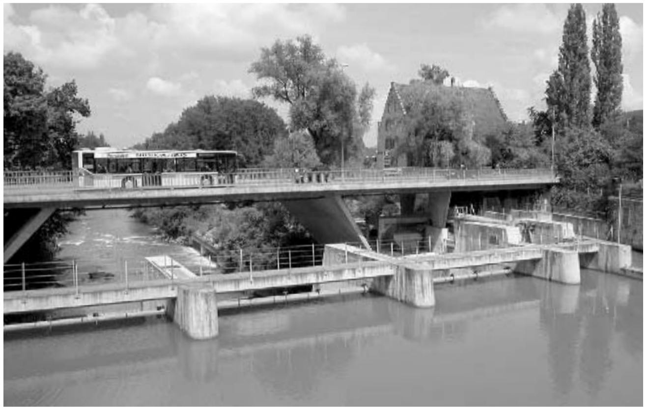
Wehr bei Dornachbrugg.
