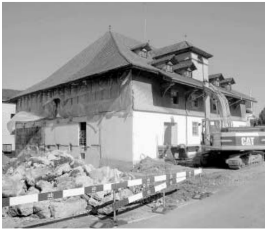
Das alte Roth-Gebäude wird abgebrochen.
