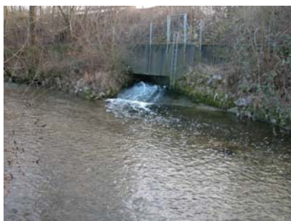
Ablauf einer Kläranlage.
