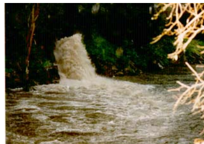
Mischwasserentlastung bei Regenwetter.
