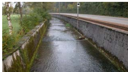
Klasse 4, künstlich / naturfremd : Begradigter Bach mit vollständig verbautem Ufer, die Sohle mit Schwellen stabilisiert.
