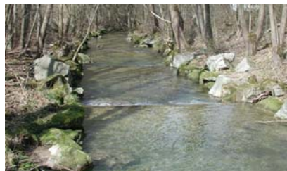
Klasse 3, stark beeinträchtigt : Der Bach ist leicht begradigt (Wasserspiegelbreitenvariabilität eingeschränkt) und die Ufer sind mit Blockwurf hart verbaut.
