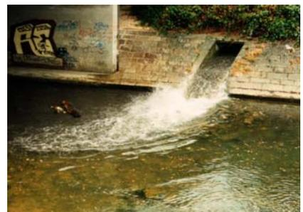
*Bei Regenwetter entlastet Abwasser aus der Kanalisation in den Fluss.*
