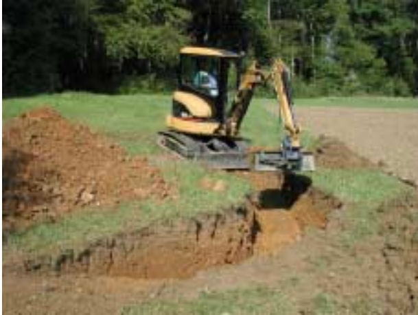
Vorbereitung der Bodengrube
