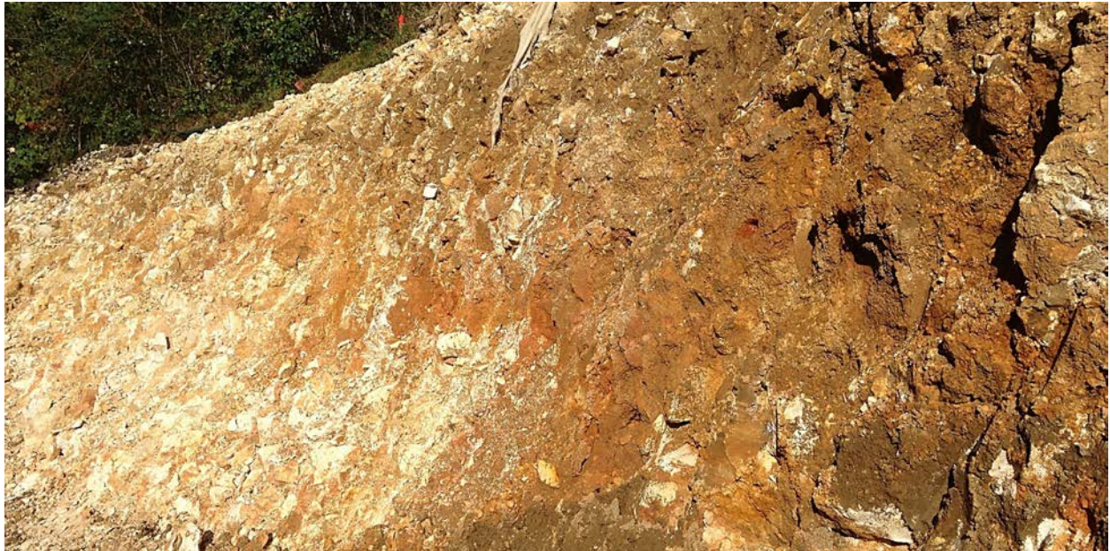
Baustellenaushub mit stark arsenhaltigen roten Klufftonen in Röschenz
