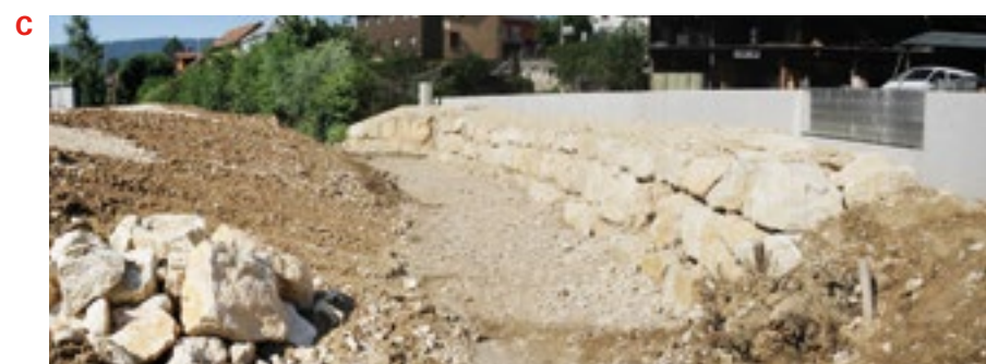
Die verlegte und ausgedolte Passage im weiteren Bachverlauf (C, Trockenzone) ist durch Blocksteinränder und Aufschüttungen begrenzt.
