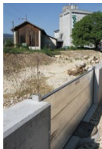
Die verlegte und ausgedolte Passage im weiteren Bachverlauf (C, Trockenzone) ist durch Blocksteinränder und Aufschüttungen begrenzt.
