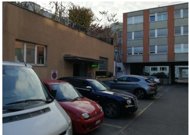
Abbildung 47: Ist-Situation des Hinterhofs
