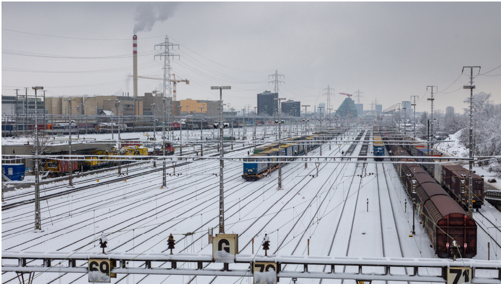
Der Rangierbahnhof Muttenz mit seinen grossflächigen Gleisanlagen ist fast nur ab der Grenzacherstrasse einsehbar.
