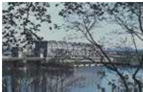
Das Rheinkraftwerk Birsfelden.
