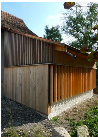
6 | Lattung als Lichtfilter und Sonnenschutz
