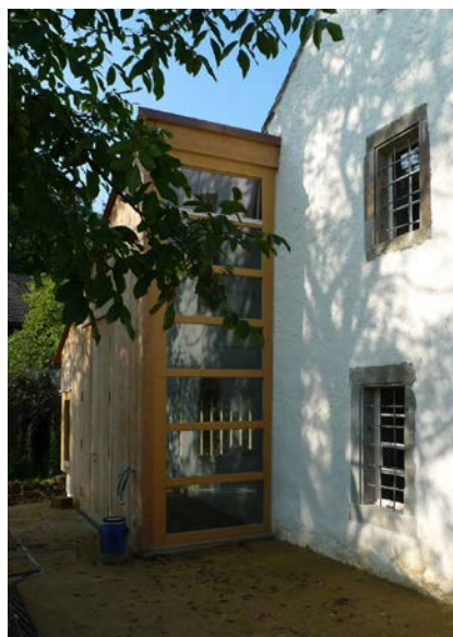
7 | Rückseitiger Anschluss an den Altbau
