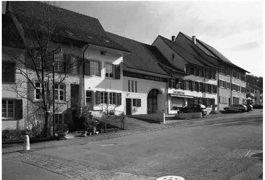
3 Dorfstrasse mit Umbauten
