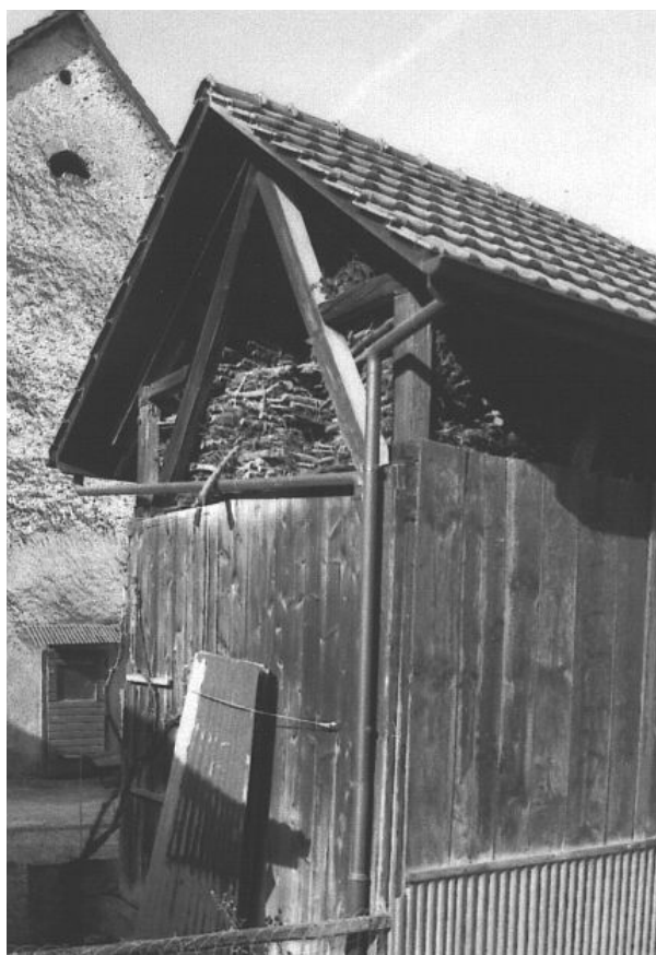
Offener Dachstuhl Ost
