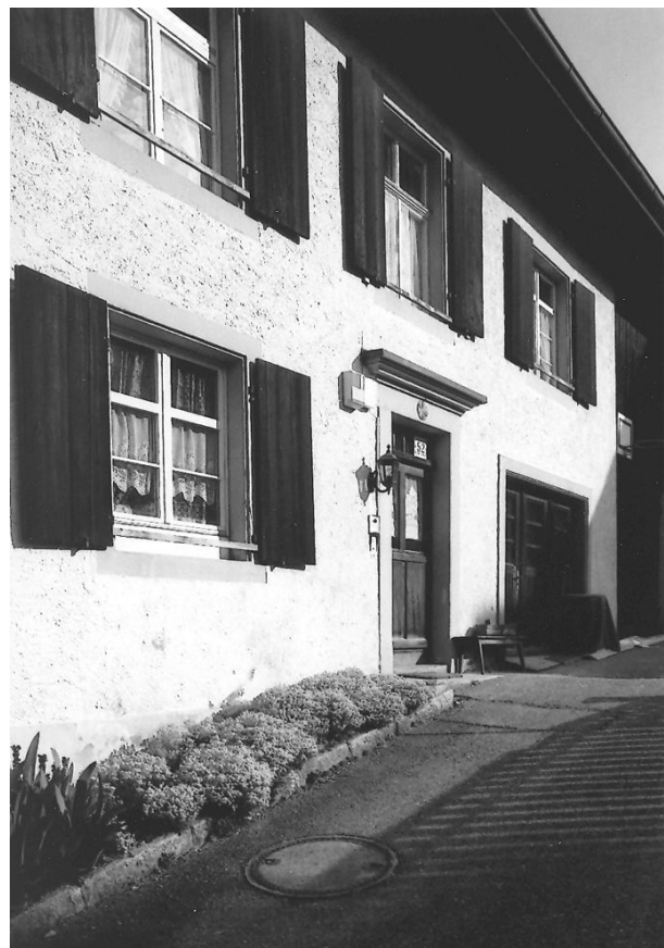
Eingang Fassade Südost
