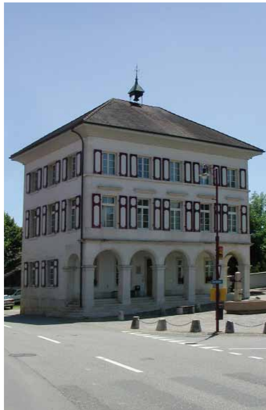
Abb.2 Aus dem Inventar der kantonal geschützten Kulturdenkmäler des Kantons Baselland: altes Schulhaus, Röschenz
