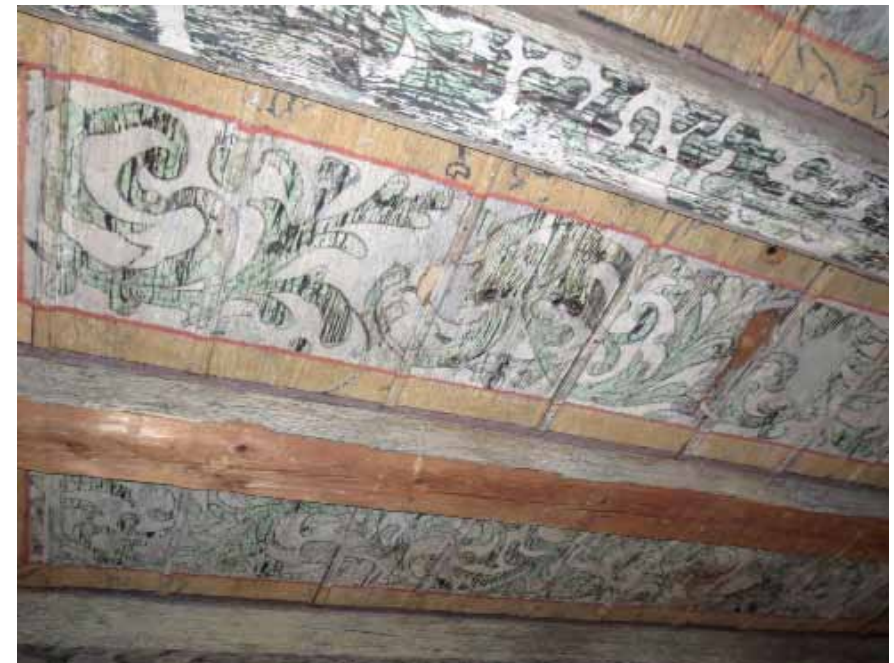
Abb.5a Renovation Sundgauerhof, Arlesheim
