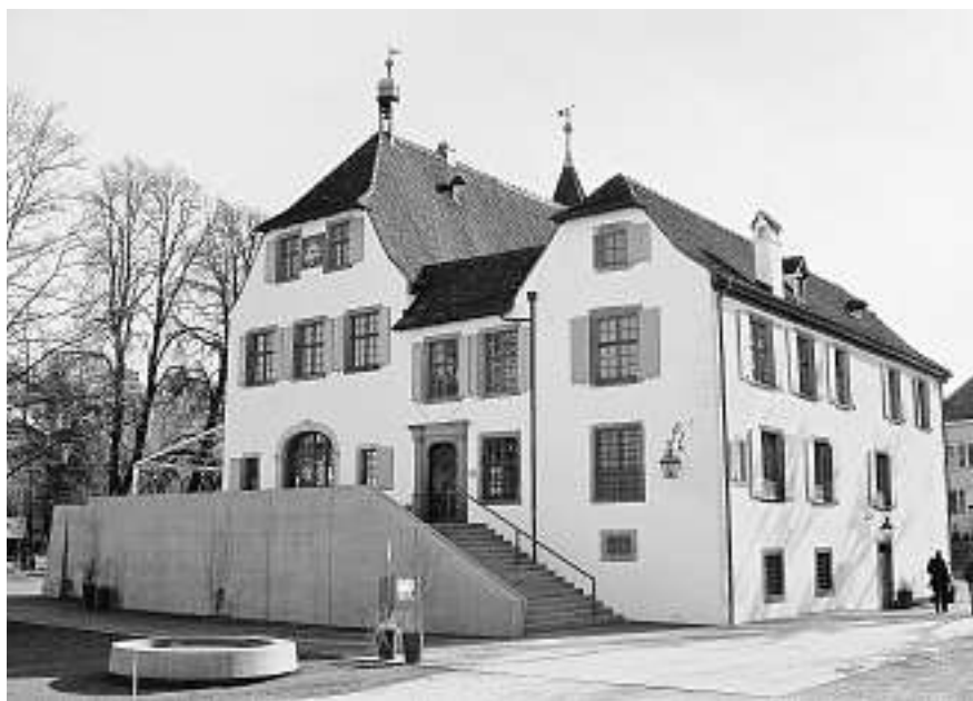
Binninger Schloss als Wasserschloss, um 1670 (Bildarchiv Kantonale Denkmalpflege) Binninger Schloss: Zustand 2009
