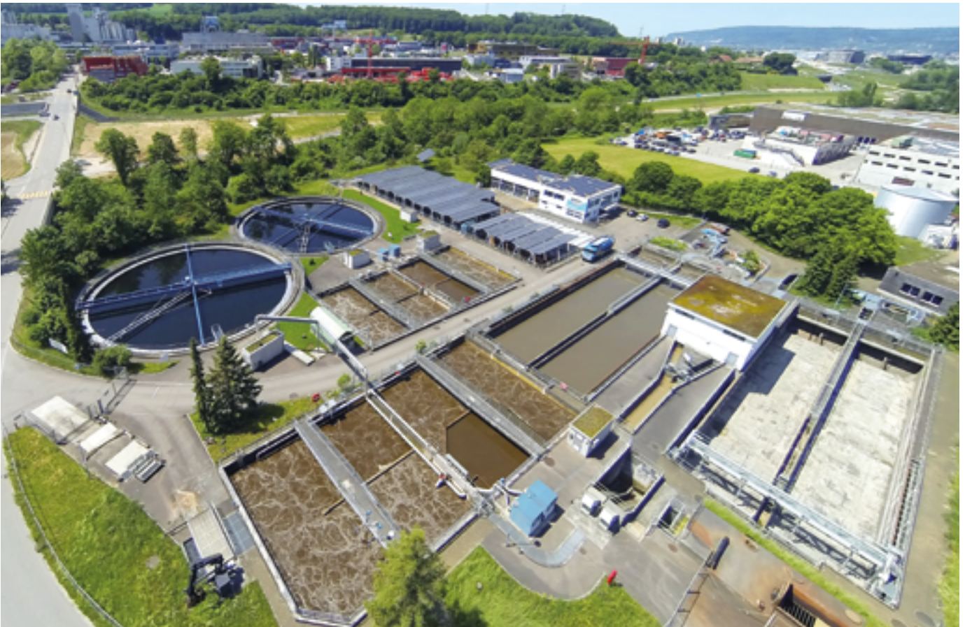
Luftaufnahme der ARA Ergolz 2 in Füllinsdorf.
