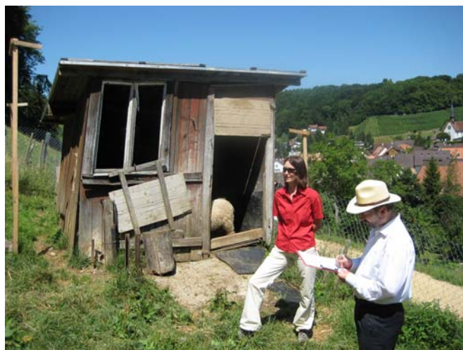
Beispiel einer konstruktiven Zusammenarbeit aller Beteiligten: Ein baufälliger Schafstall ausserhalb der Bauzone als Ausgangslage...
