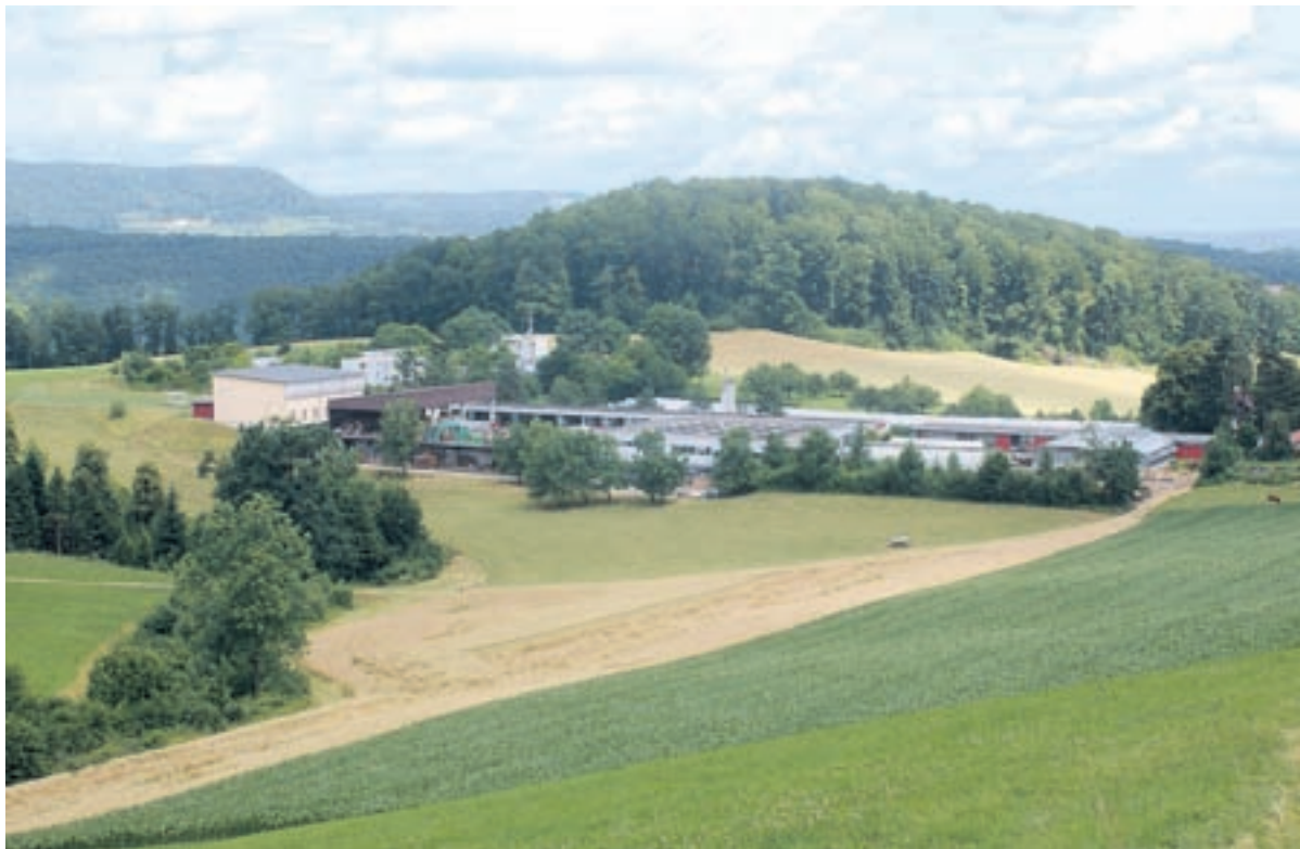
Der Arxhof bei Niederdorf. In unmittelbarer Nähe wird ein Jugendgefängnis geplant. Foto Hannes-Dirk Flury
