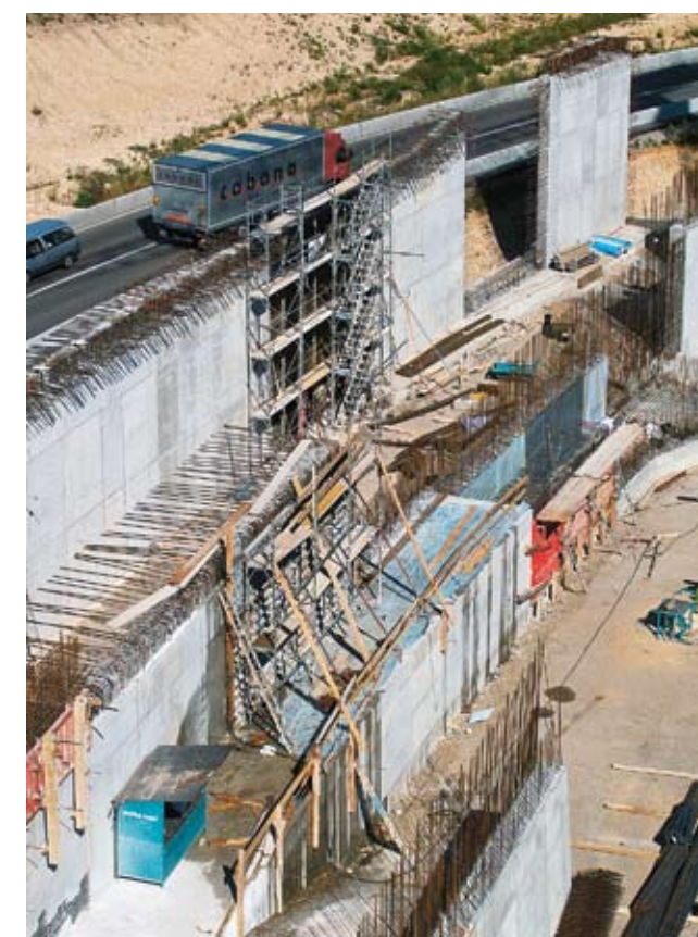
▲ Alle Baustellenfotos: Arbeiten am Anschluss Liestal Nord
