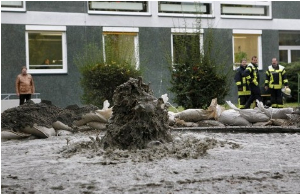
Wiesbaden: Grundwasser angebohrt
