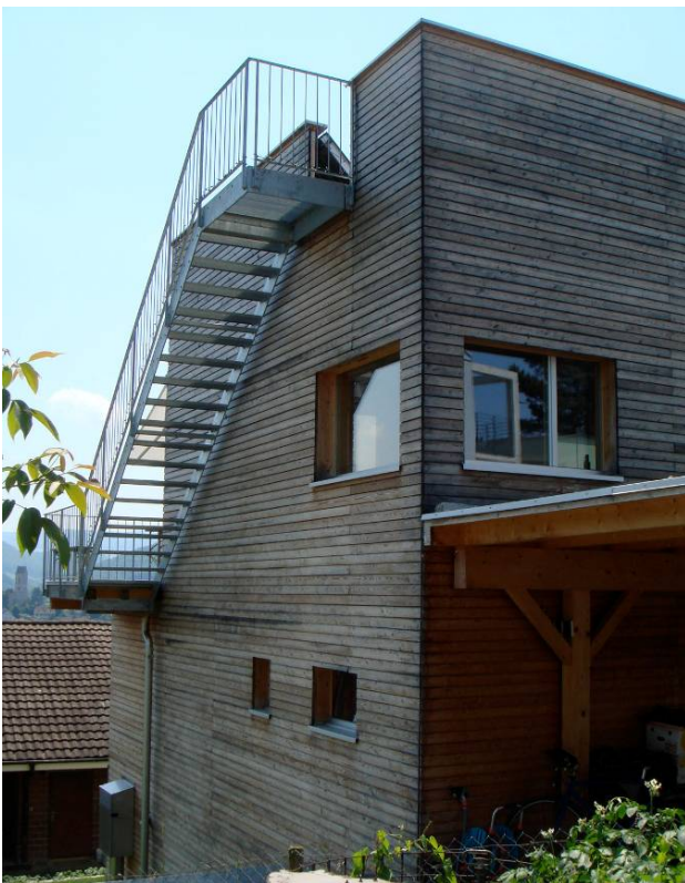
Abbildung 2: Gelterkinden - Seitenansicht mit Aufgang zur Dachterrasse
